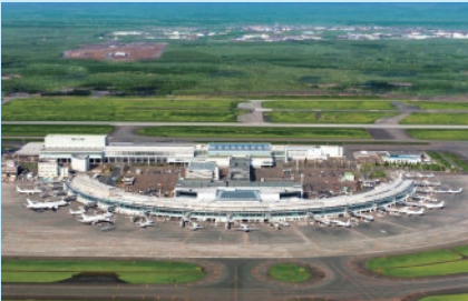
▲ 国際線ターミナルビルは当初から大幅に増築された
