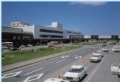
▲ 第3ビルが完成し一体化されたターミナルビル
