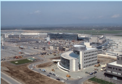
▲ 供用開始直前の新ターミナルビル
